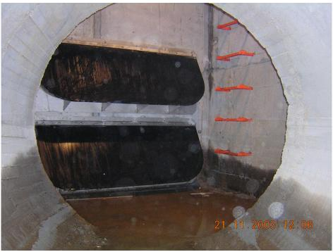
DOS CLAPETAS ALARGADAS DN 600 VISTAS DESDE EL TUBO DN 1.200 DE SALIDA DEL ESTANQUE DE TORMENTAS AL RÍO MIÑO (Porriño, Ourense).
